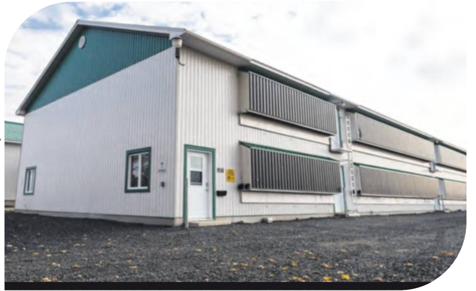
Les fermes Pierre Bélanger ont construit un nouveau poulailler en 2018. Celui-ci est doté d'un nouveau système de tunnel ventilation, de sondes et détecteurs d'humidité et de gaz carbonique et d'un éclairage à diodes électroluminescentes (DEL).
