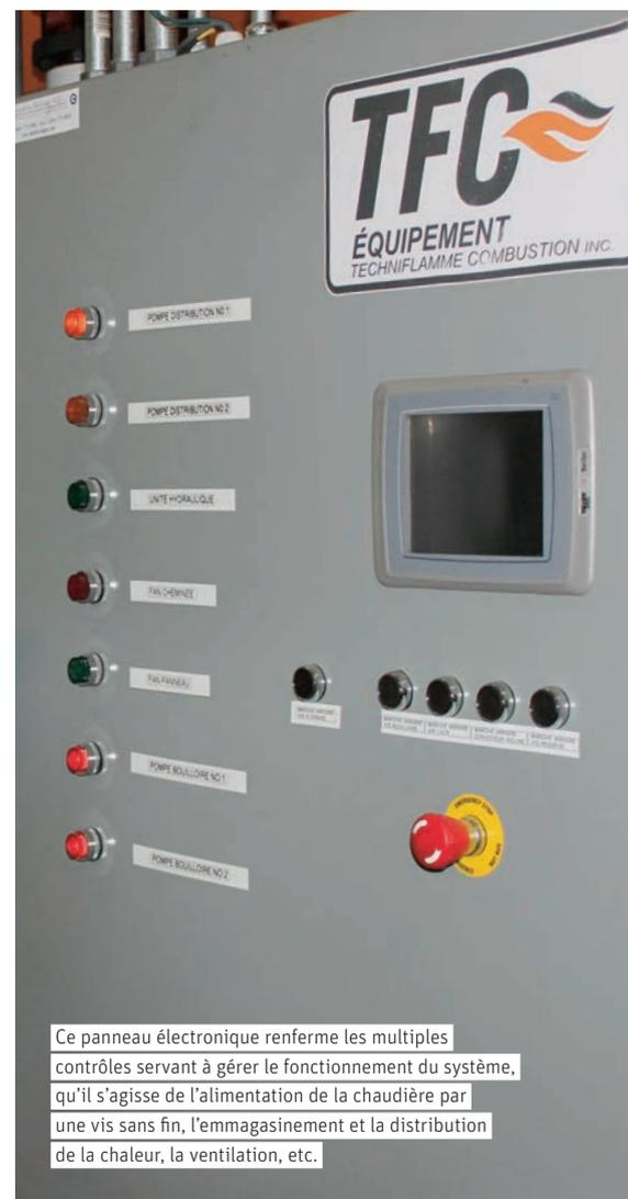
Ce panneau électronique renferme les multiples contrôles servant à gérer le fonctionnement du système, qu'il s'agisse de l'alimentation de la chaudière par une vis sans fin, l'emmagasinement et la distribution de la chaleur, la ventilation, etc.
